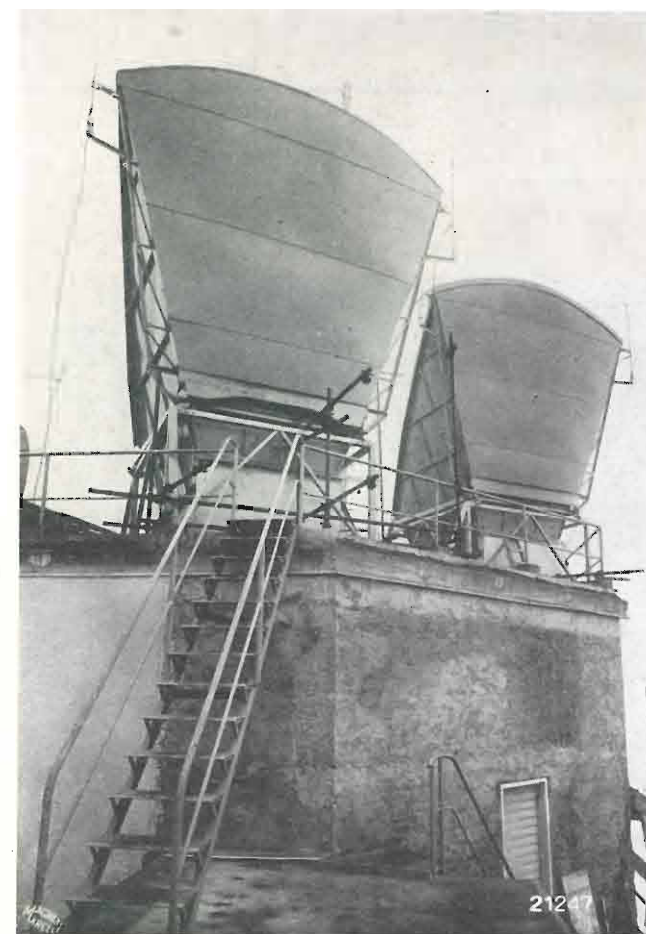
Fig. A — Stazione terminale di Milano: vista frontale delle due antenne verso Trivero.
